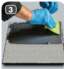
3 Aplicación de la resina epóxica 3X sobre el ROLLERKIT®
