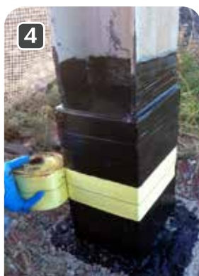
4 Нанесение эпоксидной смолы и Кевлара 3X Engineering
