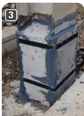
3 Монтаж металлических вкладышей
