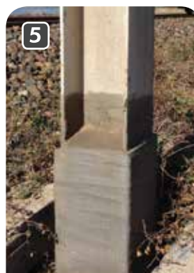
5 Монтаж защиты от ультрафиолета и от ударных нагрузок
