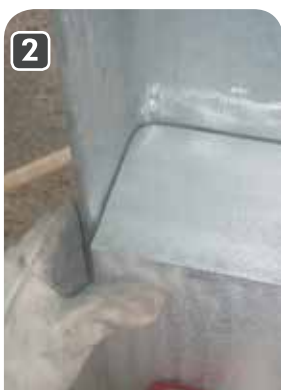
2 Подготовка металлических вкладышей
