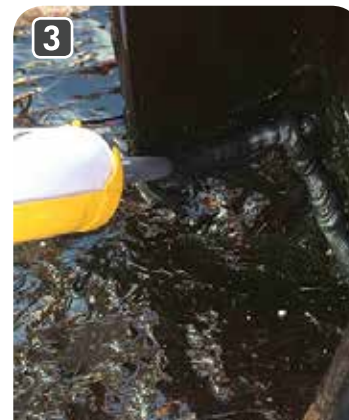
Aplicación de la resina impermeabilizante
