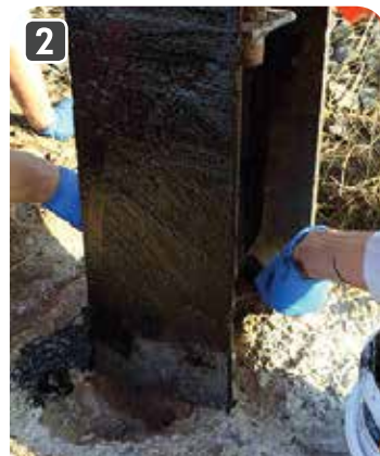
Aplicación de la resina anticorrosión
