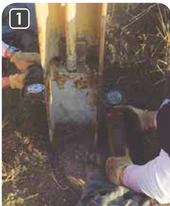
Preparación de la superficie Sa2.5
