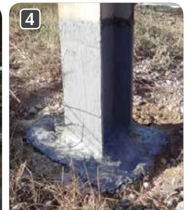
Aplicación del revestimiento protector
